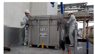
PCB安定器入りドラム缶搬出状況(鳥取工場)
